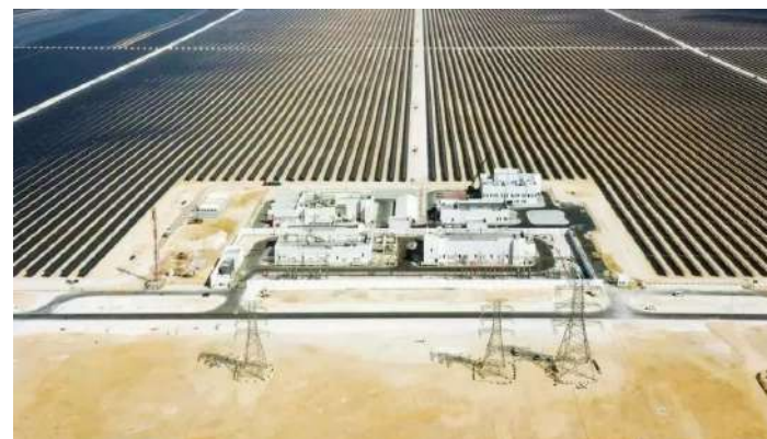
阿尔卡萨 800 兆瓦光伏电站
