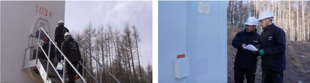
风电项目现场，停电技改升级
